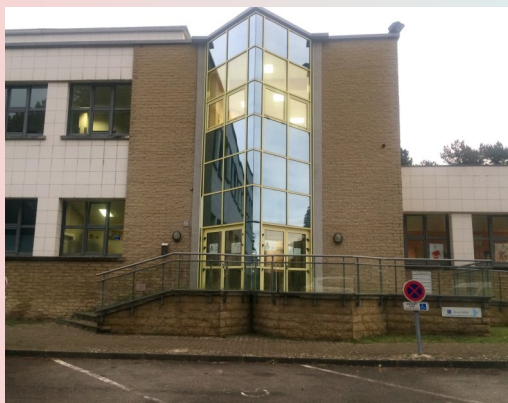
Bâtiment des consultations
